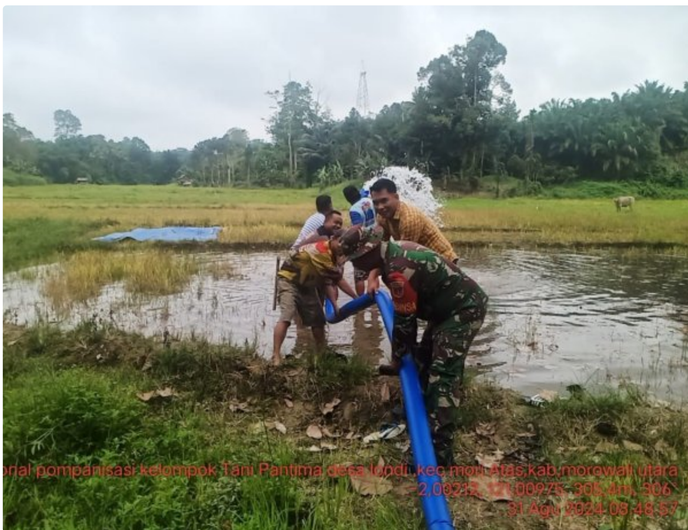
Serka Nasruddin bantu pendampingan pemasangan pompanisasi
